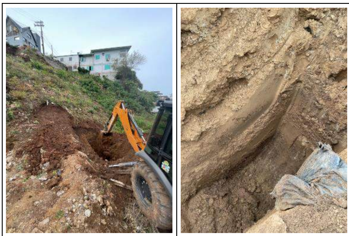
Figura 2.6 – TR03 - posicionamento e material escavado
