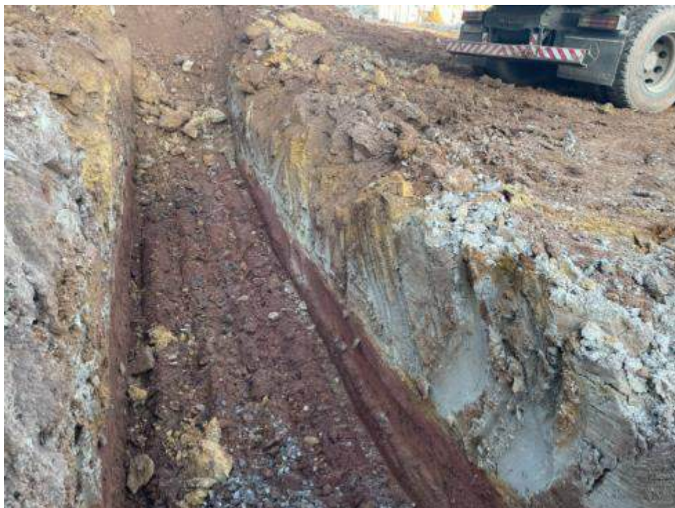
Figura 2.21 – Trincheira paralela à rua Guilherme Dal Ri - solo amigdalóide cinza claro sobre solo avermelhado.
